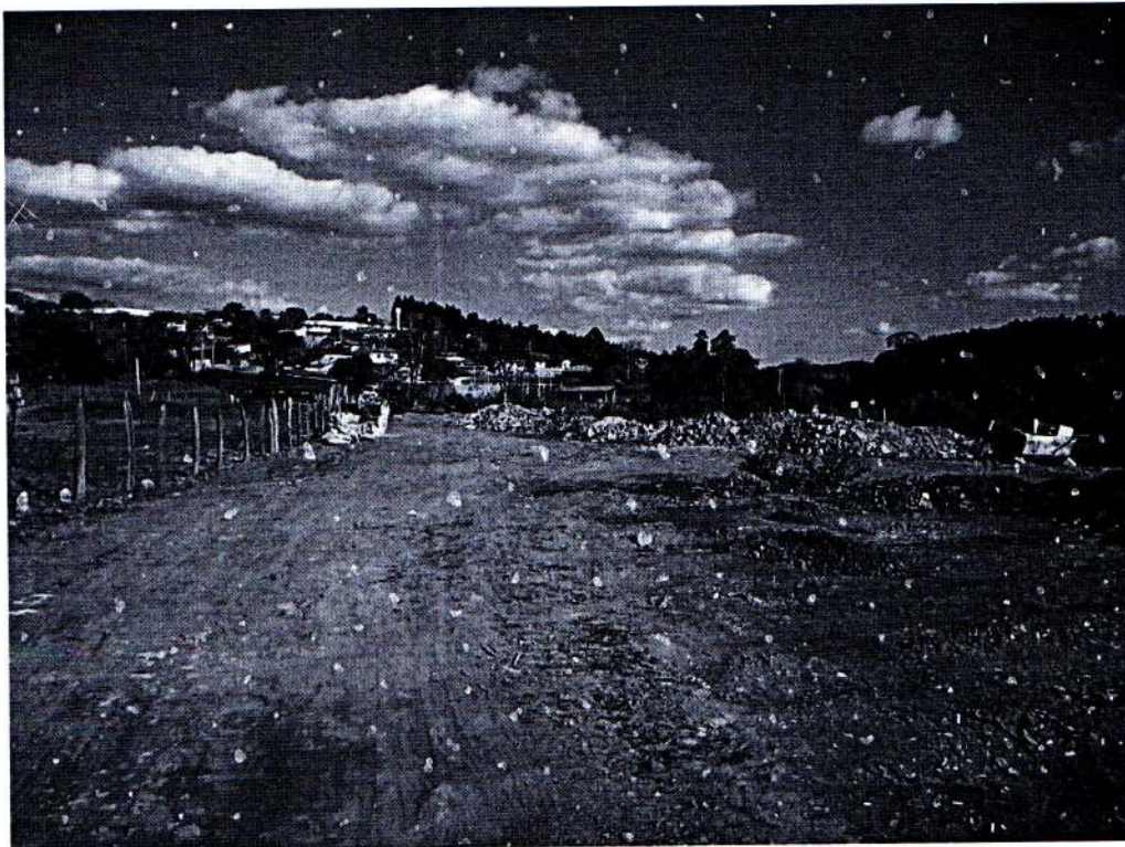
Figura 17: Resíduos da Construção Civil depositados em área licenciada
