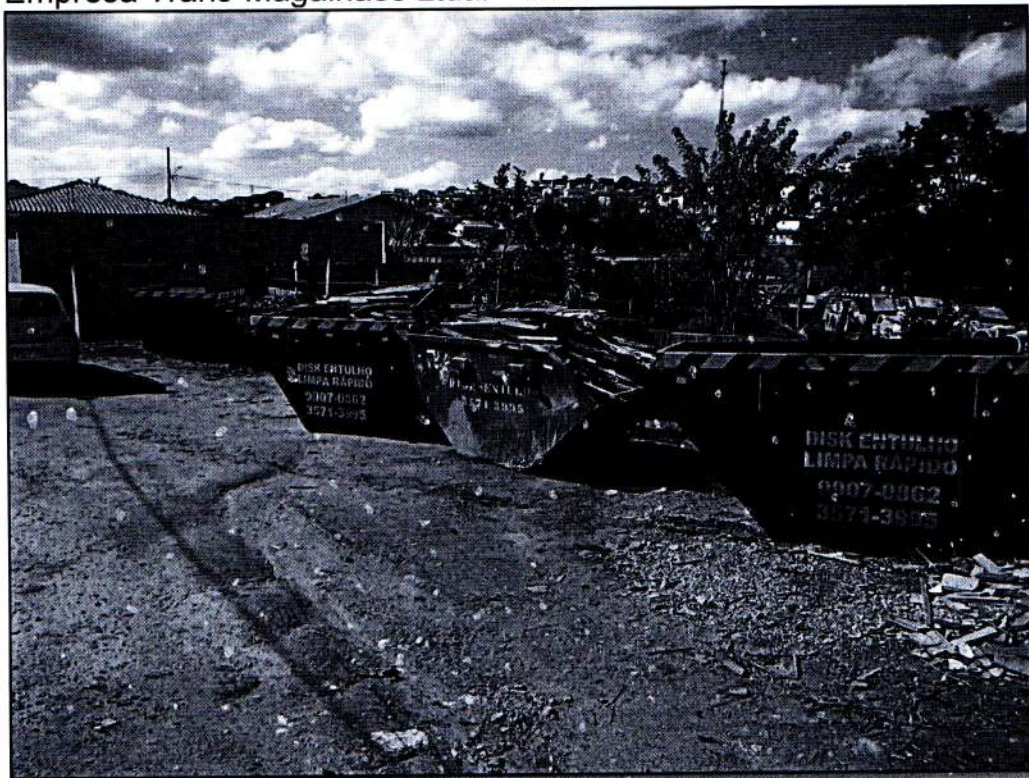
Figura 10: Área de Triagem de resíduos da construção Civil da Empresa Trans-Magalhães Ltda. – ME.
